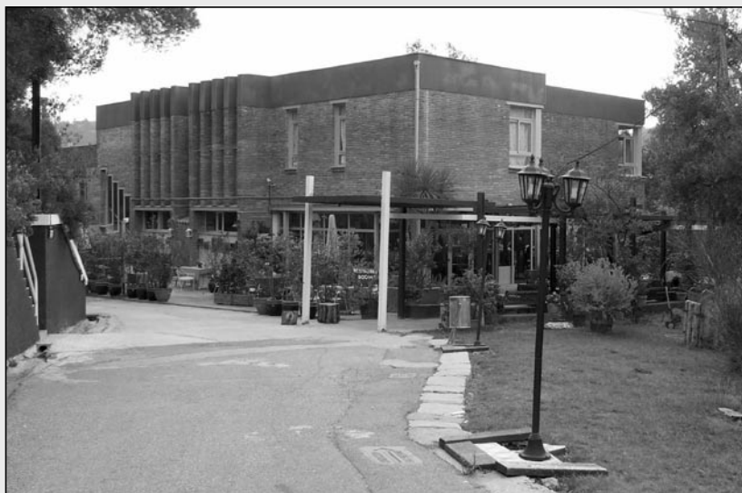
Un dels edificis de l'INOUT abans de reformar.
